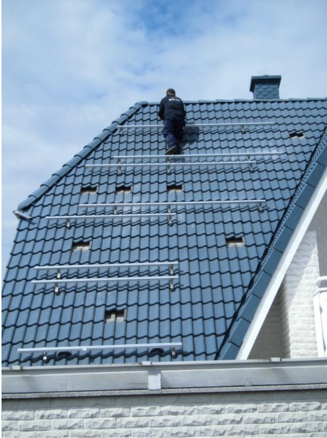
← Anbringen der Schienen
