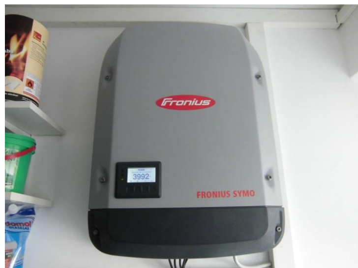
Montierter Wechselrichter->
