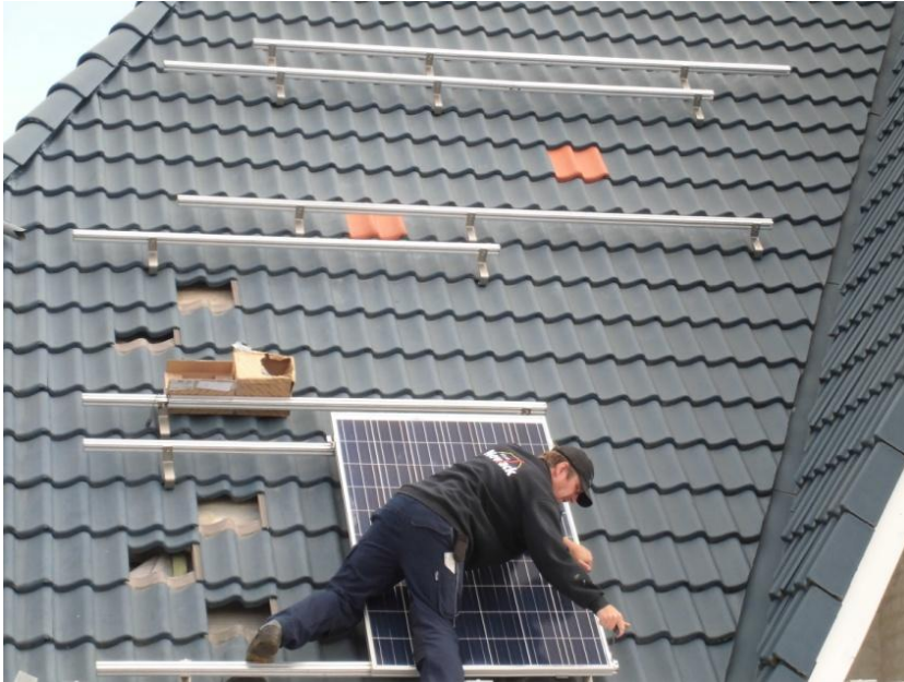
<- Montage der Module
